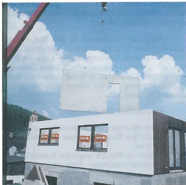
Abb. 8.1: Wohnhaus aus W-UP(Legupren)-Leichtbeton-Wandelementen; Keller und Dach sind in konventioneller Bauweise erstellt worden
