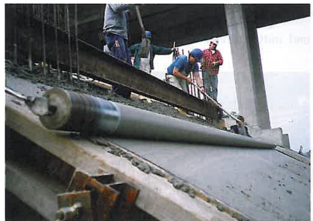
Abb. 12: Betonage des Bogens der Südbrücke (3)
