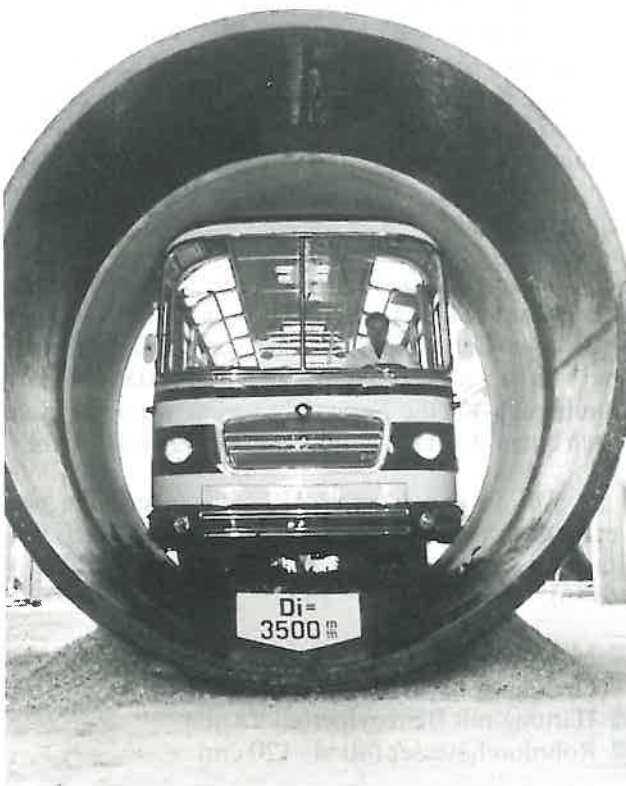
Abb. 7.3: BAU 68 in München: Das größte Schleuderrohr der Welt (Material: Polyester (UP-)Beton (Züblin, Kehl))
