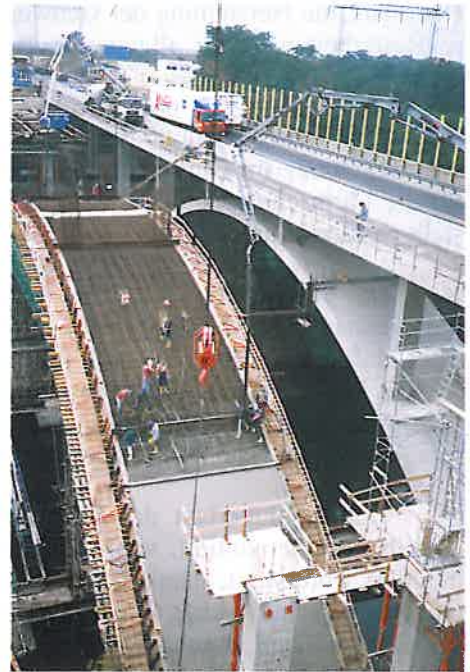
Abb. 10: Betonage des Bogens der Südbrücke (1)
