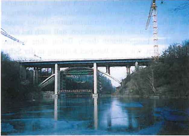
Abb. 6: Südansicht auf das alte und neue Bauwerk
