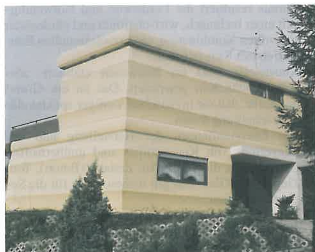
Abb. 8.2: Wohnhaus in Kombinationsbauweise: Außenwandelemente (asymmetrisch): E-UP-Leichtbeton, Keller, Innenwände und Dach in konventioneller Bauweise
