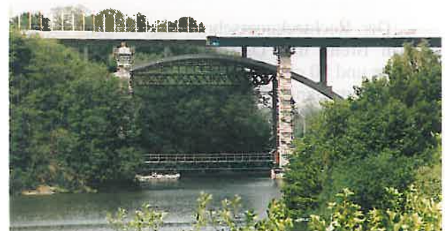
Abb. 8: Demontage der vorhandenen Stahlbrücke im Verschiebverfahren (2)
