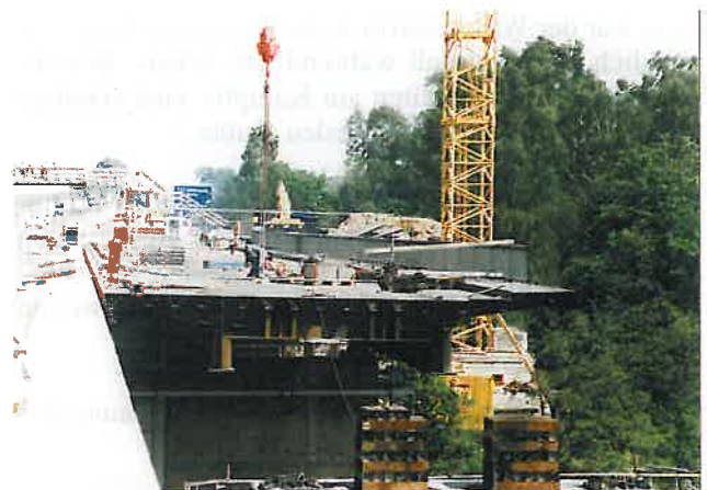
Abb. 7: Demontage der vorhandenen Stahlbrücke im Verschiebverfahren (1)
