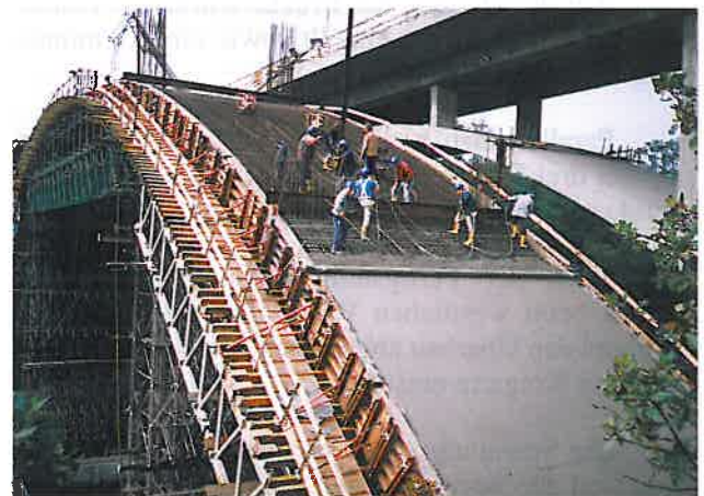
Abb. 11: Betonage des Bogens der Südbrücke (2)
