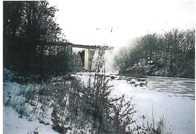
Abb. 2: Sprengung der nördlichen alten Pfeiler
