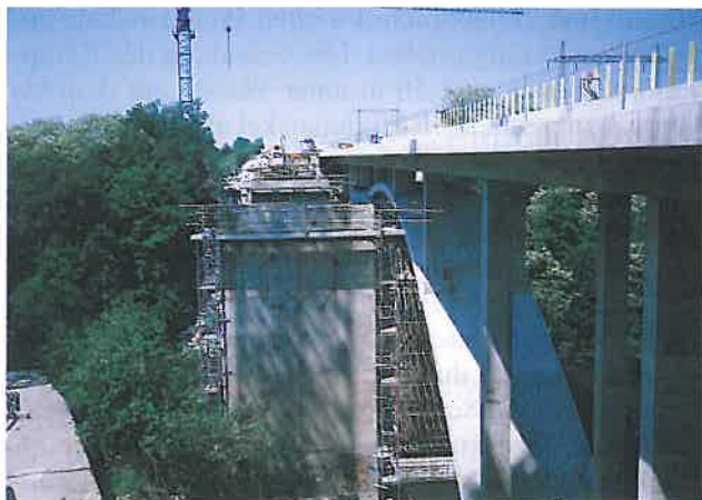
Abb. 9: Abbruch der Pfeiler auf der Südseite
