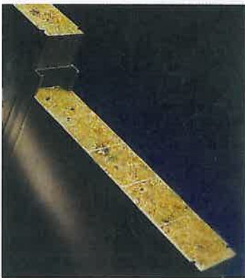
Abb. 8.6: Wandaufbau (symmetrisch) des PVC-Voll-Kunststoffhauses Quelle: Modern Plastics International
