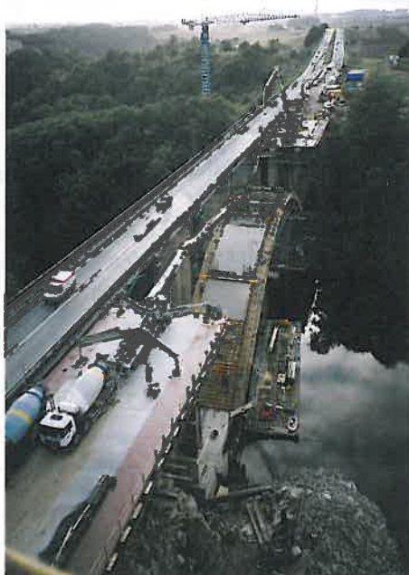
Abb. 5: Betonage des Bogens der Nordbrücke
