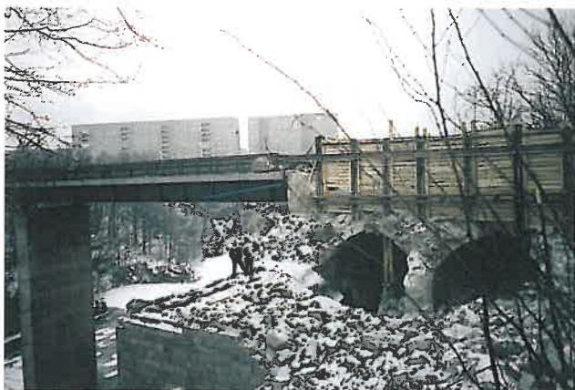
Abb. 3: Abbruch der vorhandenen Widerlager bei gleichzeitigem Verbau in der Längsachse
