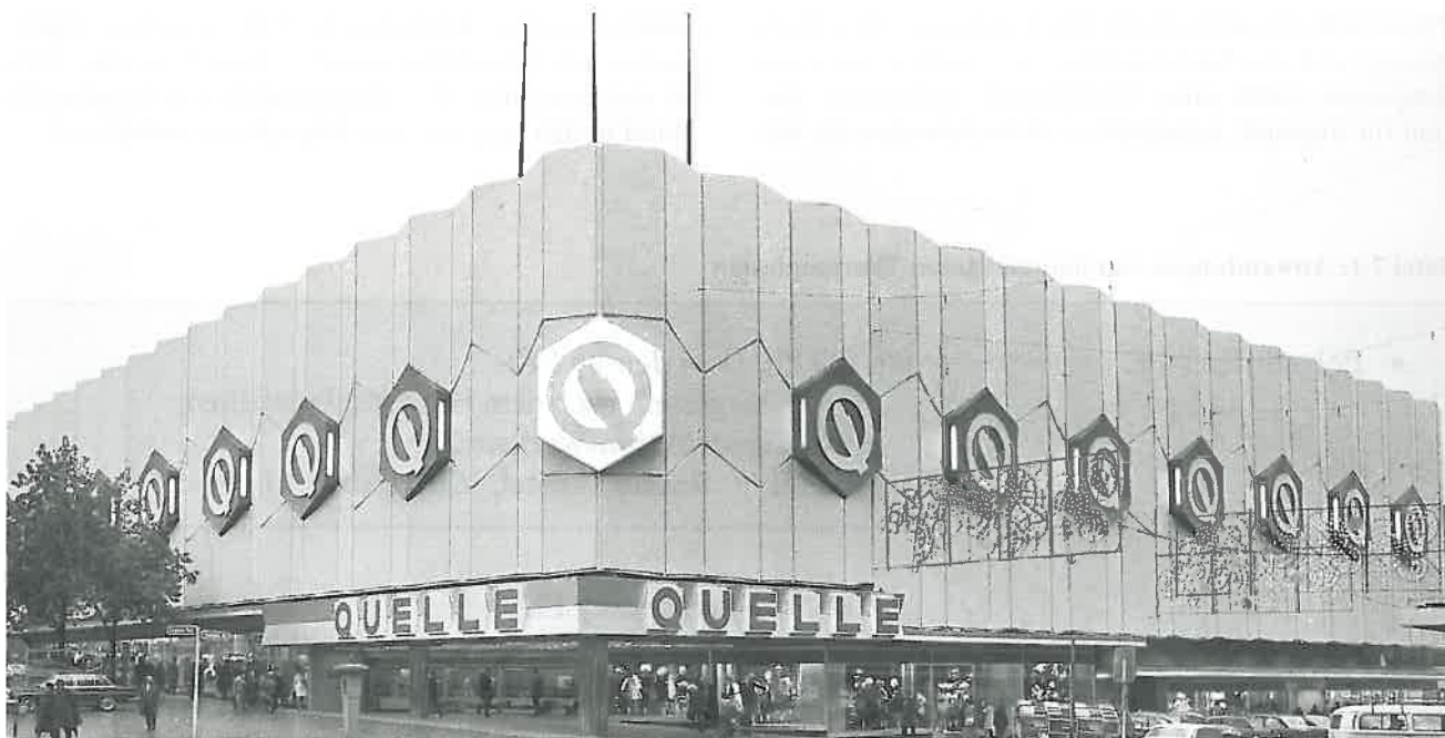
Abb. 7.1: Eine der ersten Großfassaden in Deutschland aus GF-UP erhielt ein Quelle-Kaufhaus im Ruhrgebiet (Architekt: Dipl.-Ing. Anton L. Thomas, Duisburg)
