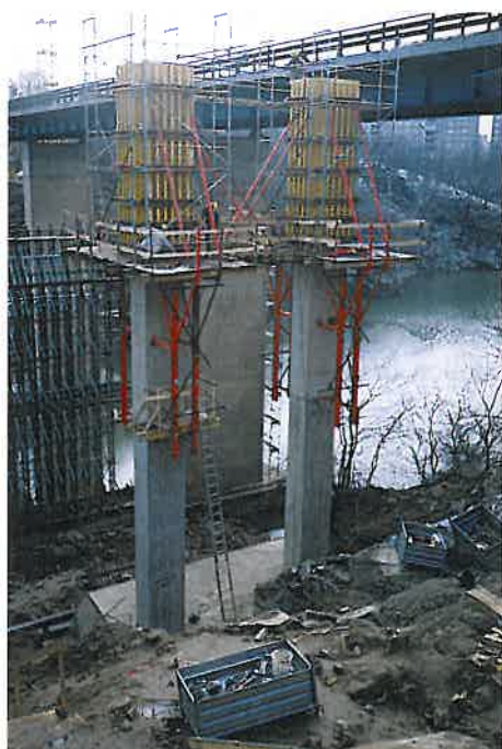
Abb. 4: Entstehung der Unterbauten der Nordbrücke
