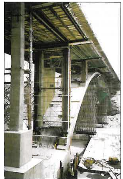
Abb. 1.2: Schweres Traggerüst
