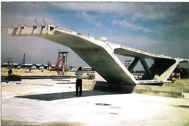
Abb. 18: Segment für eine Hochstraße in Bangkok, Thailand
