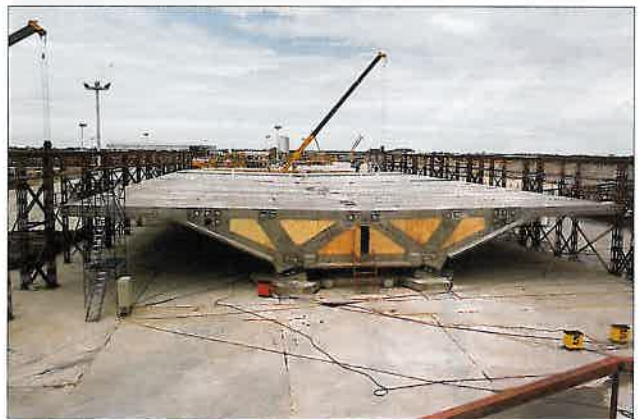
Abb. 19: Aufbau eines gesamten Brückenfeldes zur Prüfung (Testspan)
