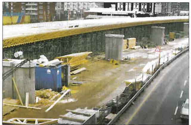
Abb. 1.1: Traggerüst aus Lasttürmen
