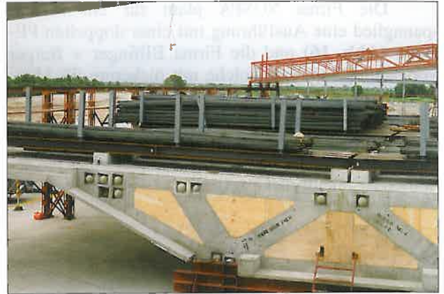
Abb. 23: Belastung des Brückenfeldes durch Bewehrungsstahlbündel
