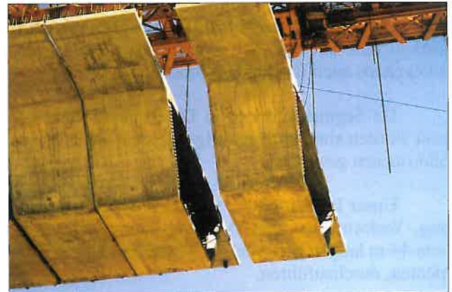
Abb. 24: Verlegung der Segmente
