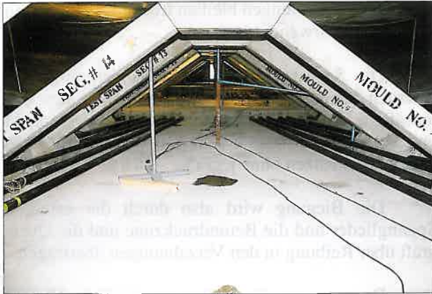
Abb.21: Innere des Hohlkastens mit externen Spanngliedern der Fa. Bilfinger + Berger
