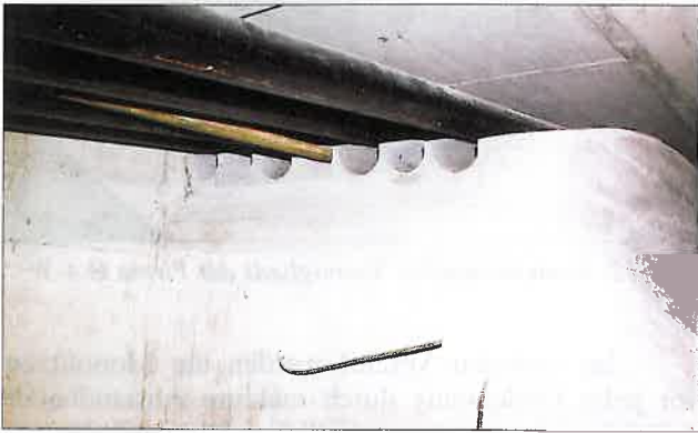
Abb. 6: Umlenksattel für externe Spannglieder in der Brücke Preonzo-Claro
