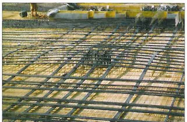
Abb. 1: Flachdecke mit Monolitzen (Verbundlose Vorspannung)
