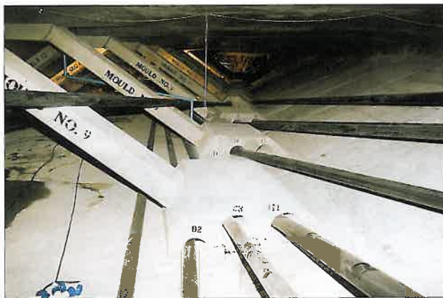
Abb. 22: Innere des Hohlkastens mit externen Spanngliedern der Fa. Bilfinger + Berger
