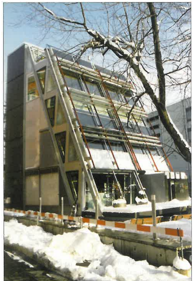
Abb. 9: GFK-Gebäude Eyecatcher (System: Fiberline)
