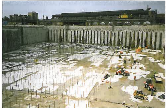
Abb. 8: Baugrube C vor dem Lehrter Bahnhof
