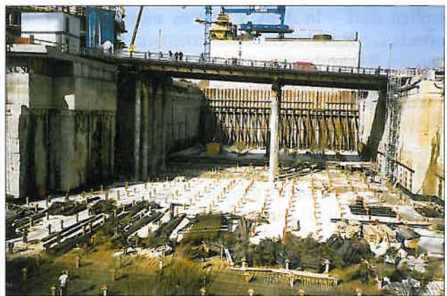
Abb. 9: Baugrube Regionalbahnhof Potsdamer Platz, Nordabschnitt
