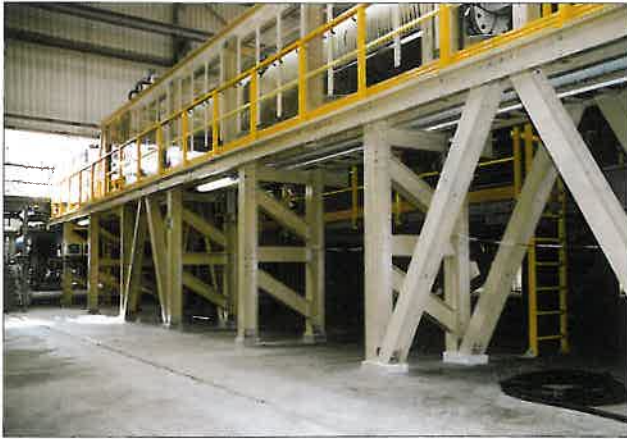
Abb. 10: Begehungsstufe aus GFK-Profilen (System: Derakane)
