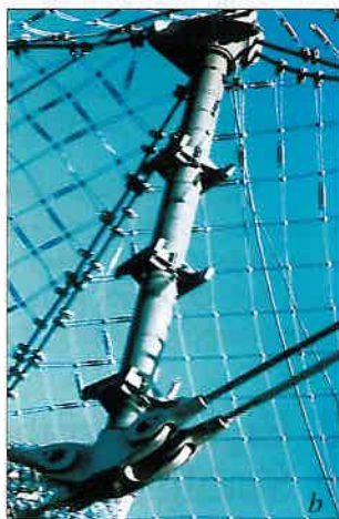
Abb. 2: Olympiadach München, 1972. Stahlgussknoten zur Koppelung von Seilen a) Ausführung, b) Schaumstoffmodell, c) fertig eingebaut
