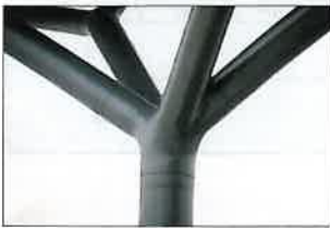
Abb. 14: Straßenüberführung über A8 bei Leonberg, 1998
