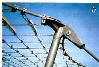
Abb. 4: Eissporthalle München, 1985. Netzabspannung a) Zeichnung, b) Ausführung
