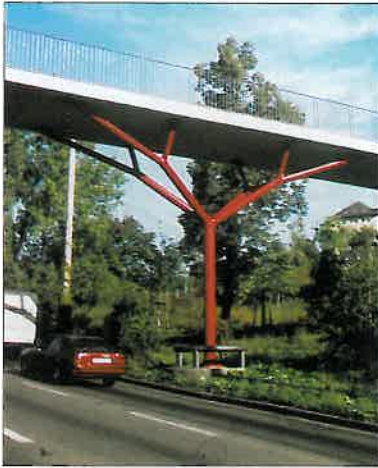
Abb. 10: Fußgängerbrücke am Pragsattel in Stuttgart, 1992.
