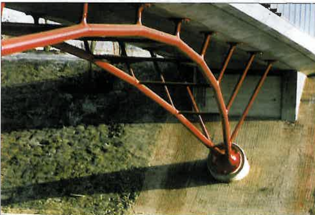
Abb. 11: Fußgängerbogenbrücke am Pragsattel in Stuttgart, 1992.
