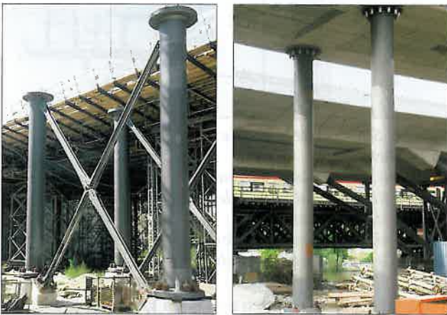
Abb. 19: Plattenbalkenbrücke auf Stahlrohrstützen (im Bau)
