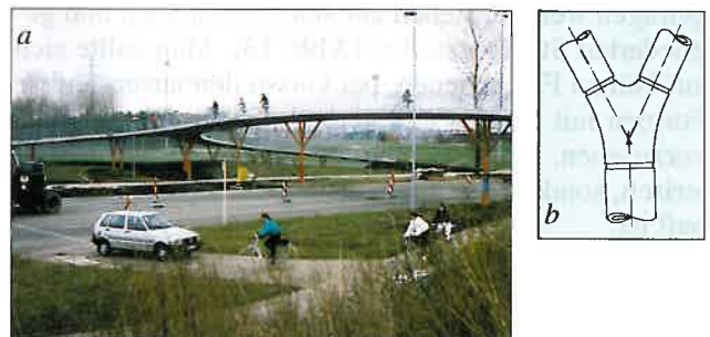
Abb. 9: Fußgängerbrücke in Sindelfingen, 1989. a) Gesamtansicht, b) Gussknotendetail
