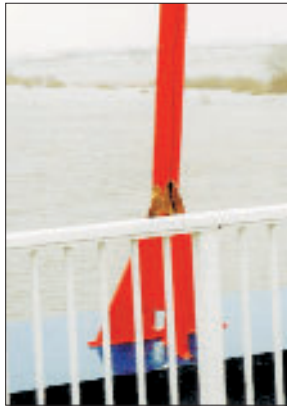
Abb. 5: Ermüdungsrisse am Hänger einer Bogenbrücke
