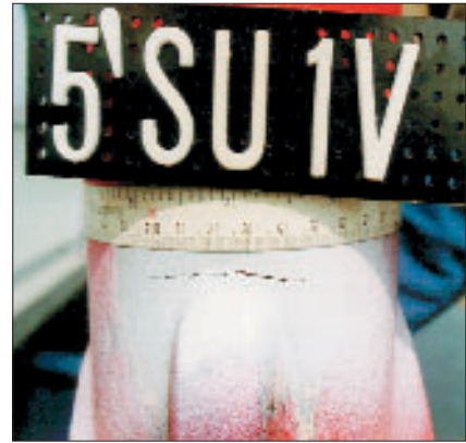
Abb. 5: Ermüdungsrisse am Hänger einer Bogenbrücke
