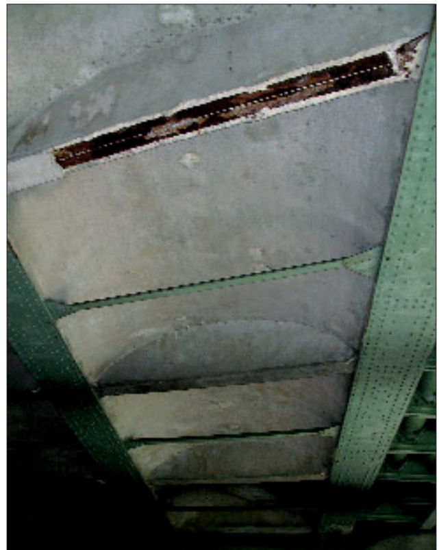
Abb. 14: Brückenuntersicht; Gewölbe zwischen Hauptträgern mit Zugbändern
