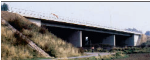
Abb. 3: Ansicht einer Spannbetonbrücke
