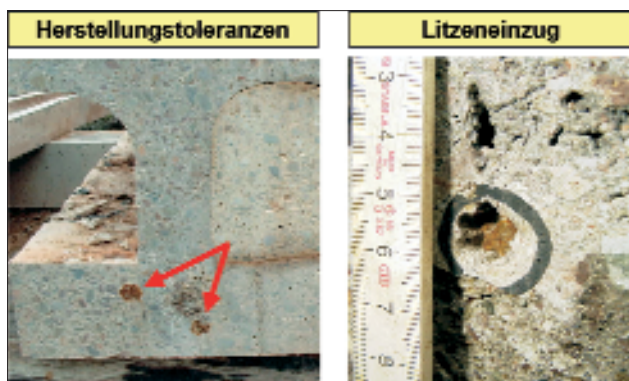
Abb.13: Kontrolle von Herstellungstoleranzen und Litzeneinzug
