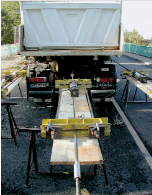
Abb. 13: Horizontallasterzeugung mittels hydraulischer Pressen
