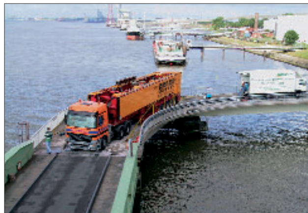
Abb. 16: Aufbau BELFA auf dem Fähranleger Blexen
