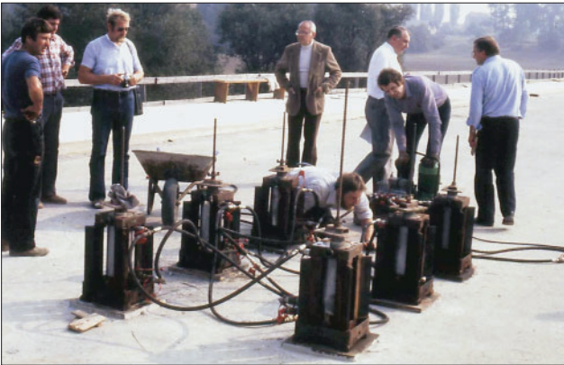
Abb. 7: SLW-Belastung der Fahrbahnplatte mit hydraulischen Pressen
