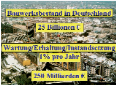
Abb. 6: Wartungsaufwand der heutigen Bausubstanz
