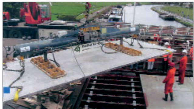
Abb. 15: Montage einer Brückendecke aus Beton B200 mit Fasern und Bewehrungsstahl
