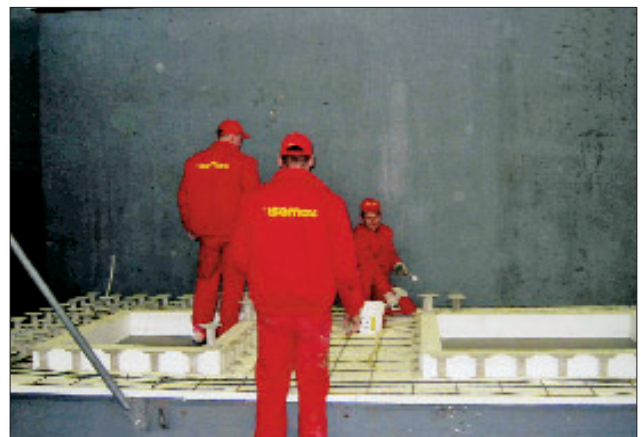
Abb. 3: Herstellung der Wände
