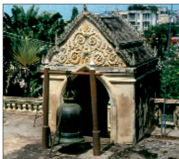
Abb. 1: Ursprüngliche Glockenaufhängung: ein einfacher Balken.
