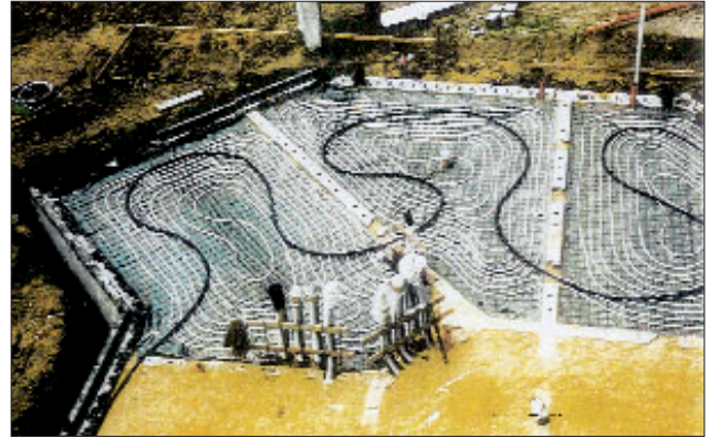
Abb. 2: Verlegung der Rohrleitungen in einer Bodenplatte vor dem Betonieren
