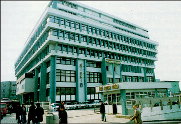
Abb. 3: Verwaltungsgebäude der Wasserversorgung von Istanbul
