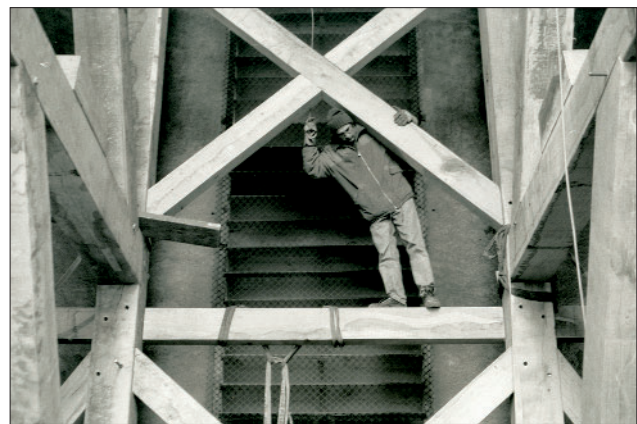
Abb. 11: Glockenstuhl in Holzbauweise
