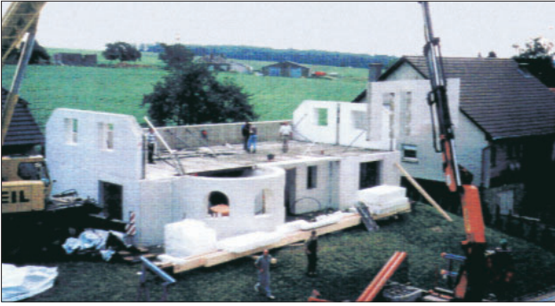
Abb. 4: Montage von Großwandelementen mit integrierten Rohrleitungen
