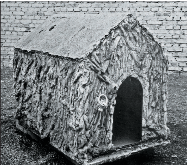
Abb. 5: Hundehütte aus Eisenbeton von 1884, erstes Versuchs-„Bauwerk“ von C. Freytag (heute im Deutschen Museum in München) [14]
