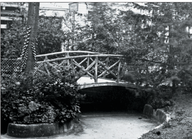
Abb. 6: Kleine Fußgängerbrücke aus Eisenbeton in Neustadt a. d. Haardt [14]
