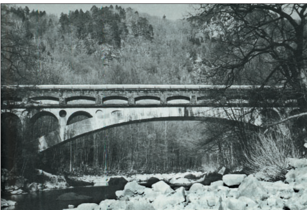
Abb. 3: Aquädukt aus unbewehrtem Beton von 1885 über die Murg bei Langenbrand (Kreis Rastatt) mit einer Spannweite von 40 m [6]
