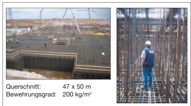
Abb.6: Bewehrung des Treppenturmfundaments des Kraftwerks Neurath
