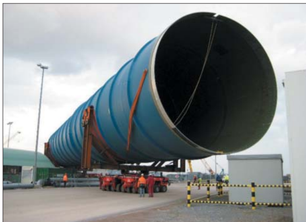
Abb. 9: Kraftwerk Neurath: Transport der Reingasleitung zum Kühlturm
