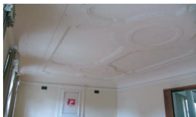
Abb. 14: Stahlbetondecke in einem alten Verwaltungsgebäude (Denkmalschutz)
