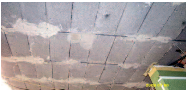
Abb. 9: Stahlbetonbalkendecke mit Füllkörpern (laufen unter Träger durch)
