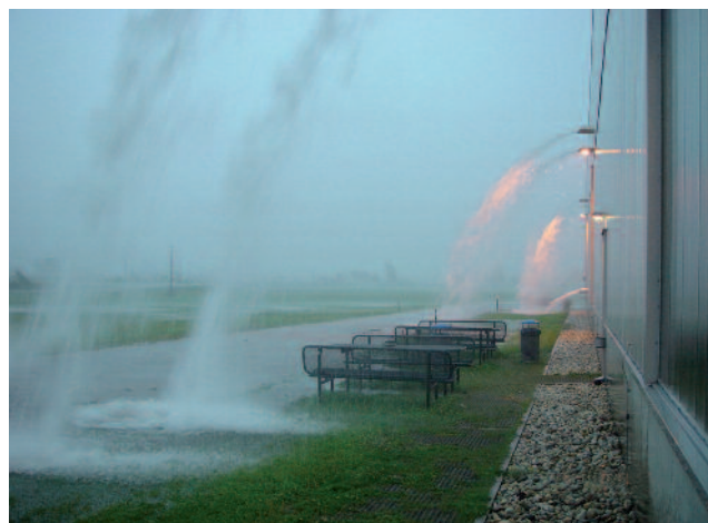
Abb. 8: Intakte Notüberläufe bei Starkregenereignis
