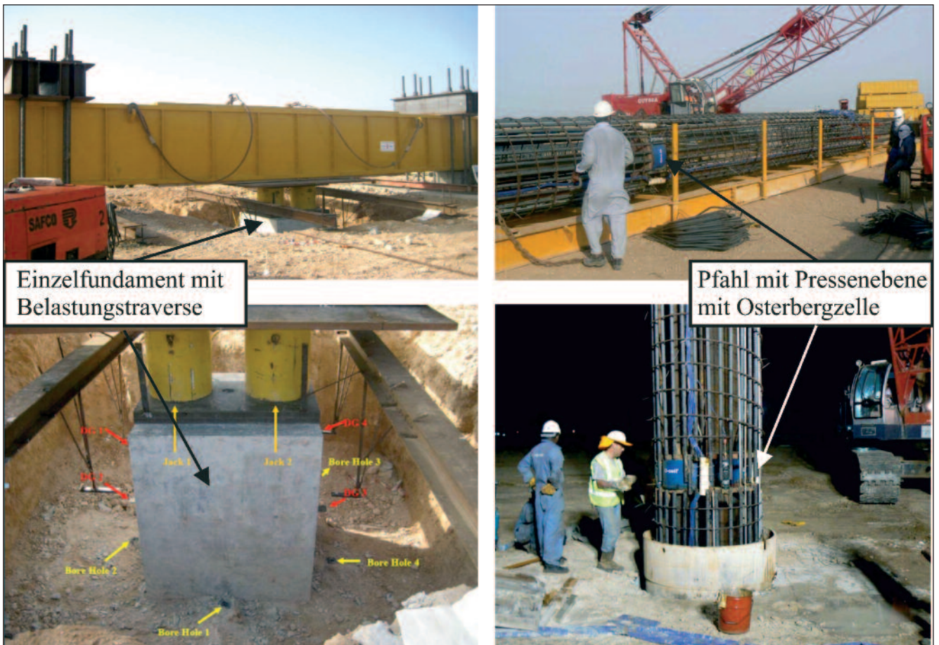
Abb. 22: Links: Probelastung Einzelfundament, rechts: Probepfahl mit Osterbergzellen
