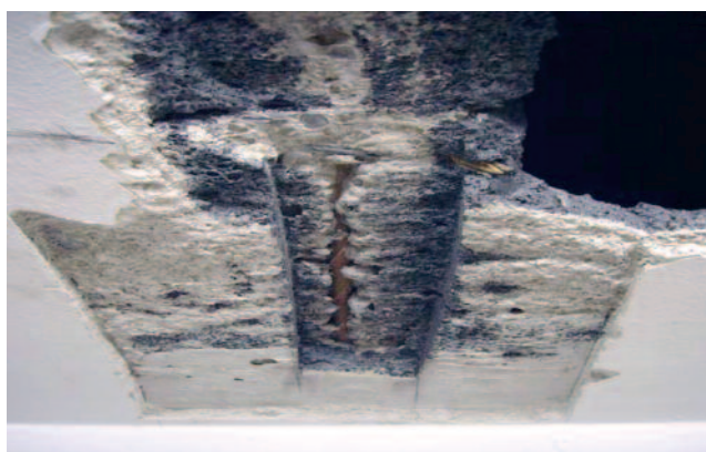
Abb. 13: Deckenansicht der Decke nach Abb. 12
