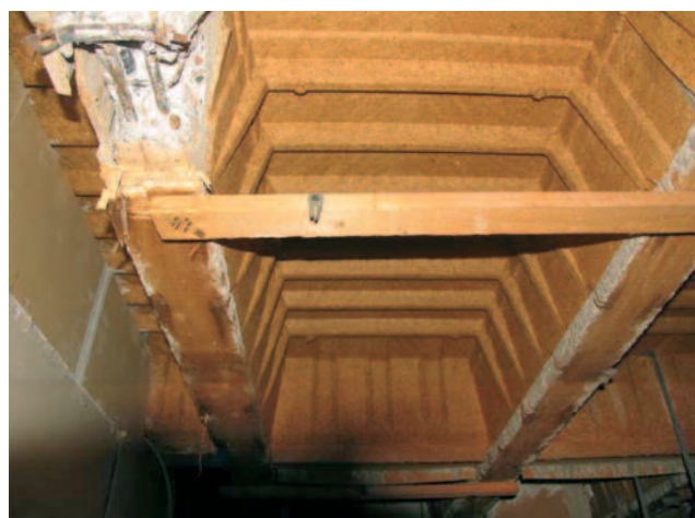
Abb. 6: Rippendecke mit verllorener Holzschalung
