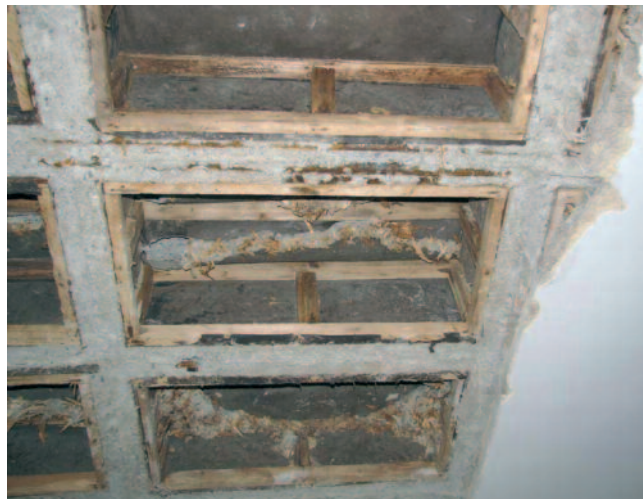
Abb. 1: Rippendecke mit Schalkkörpern, HWL-Platten und Putz
