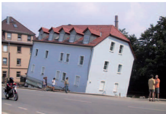
Abb. 6a und Abb. 6b: Beispiele für Totalschäden durch Hochwasser, August 2002
