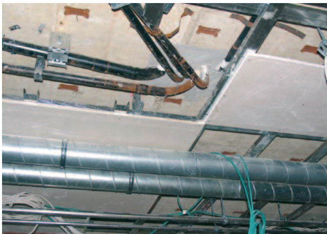
Abb. 4: Geplante Nachrüstung durch eine F 90-Unterdecke (allein)
