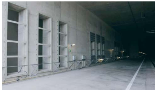
Abb. 12: Seitliche Öffnung des Sonic Boom-Bauwerks am Südportal
