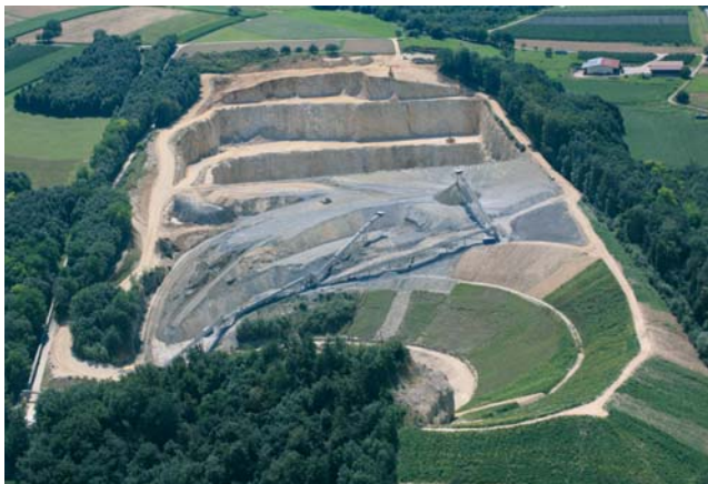
Abb. 5: Deponiefläche im Steinbruch „Kapf“
