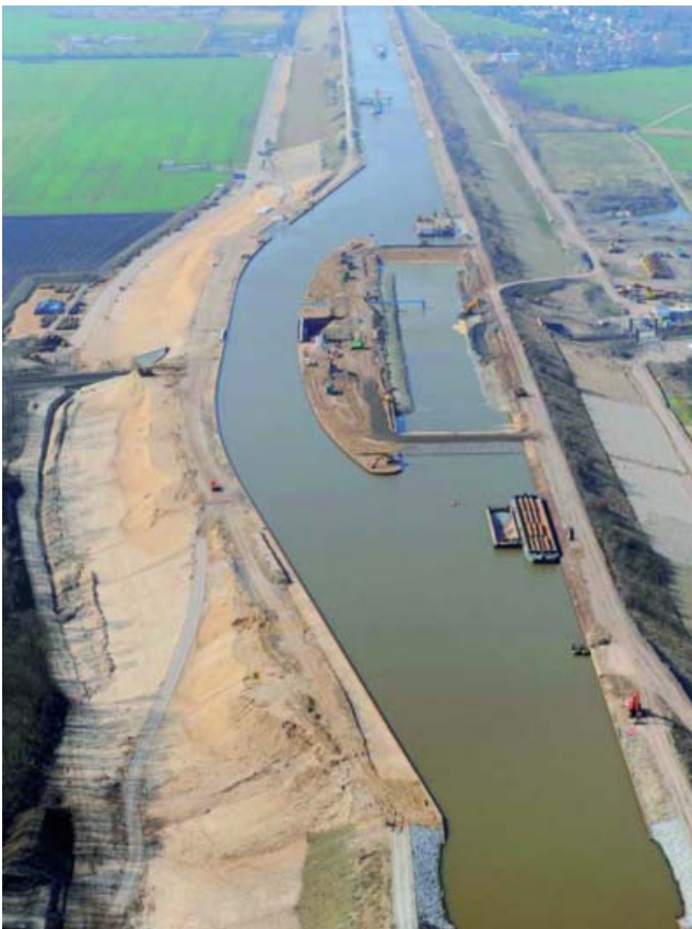
Abb. 12: Ausweiche in Betrieb, Alte Fahrt gelenzt
