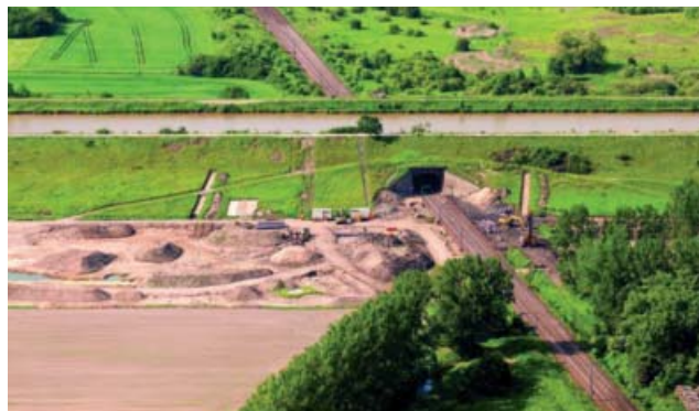
Abb. 2: Die Kanalüberführung Elbeu vor Beginn der Bauarbeiten
