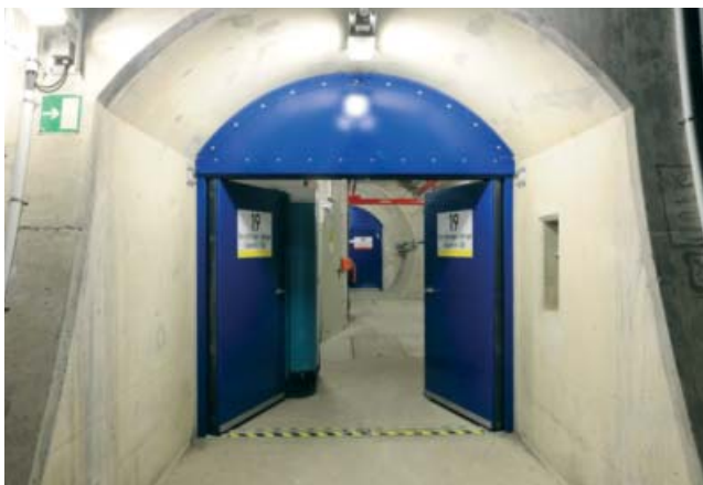
Abb. 17: Verbindungsbauwerk mit Rettungsschleuse
