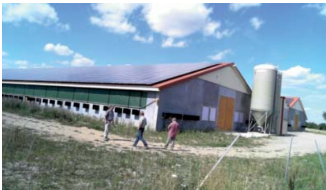
Abb. 7: Vorderansicht der Stallanlage zur Legehennenaufzucht
