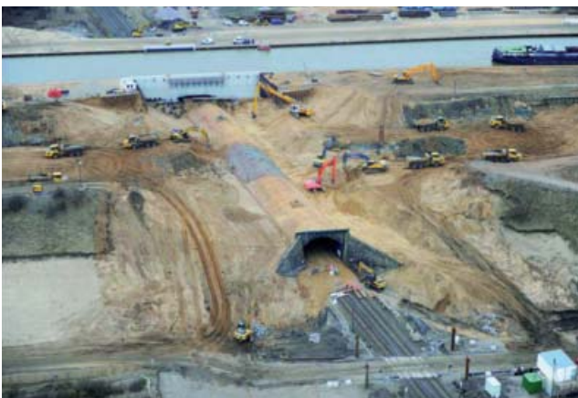
Abb. 13: Abbruch Tunneldecke in zweiwöchiger Sperrpause der Bahn
