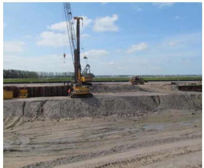
Abb. 14: Spundwandeinbau im Bereich der Alten Fahrt
