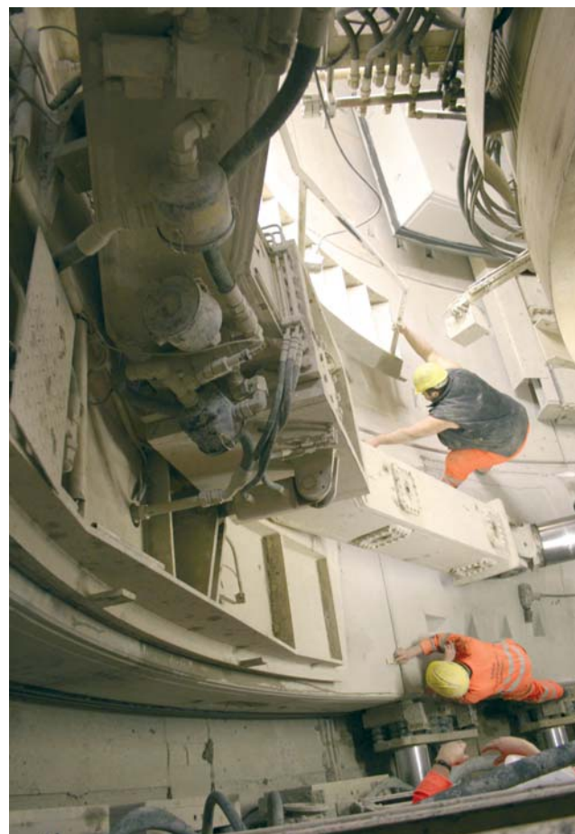
Abb. 8: Einbau eines Tübbings
