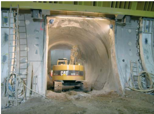
Abb. 9: Baggervortrieb im Querstellen
