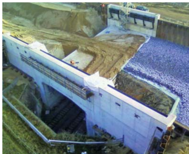
Abb. 9 und 10: Rohrdurchführungen der Verankerungselemente, Ansicht der Flügelwände
