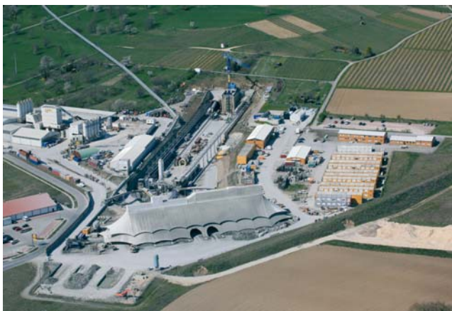
Abb. 4: Baustelleneinrichtungsfäche am Südportal des Katzenbergtunnels
