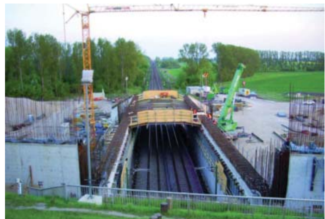
Abb. 6: Herstellung der Rahmenstiele und -riegel der einschiffigen Kanalbrücke
