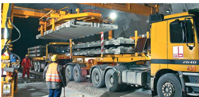
Abb. 14: Der hohe Vorfertigungsgrad ermöglicht kurze Einbauzeiten
