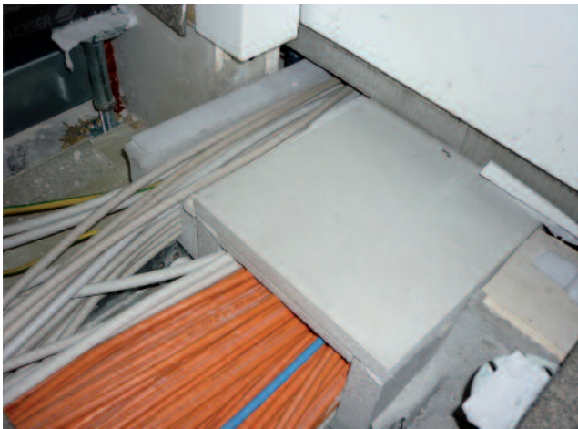
Abb. 4: Ungeschottete Leitungsdurchführungen
