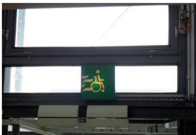
Abb. 4: Ausweisung eines barrierefreien Rettungsweges
