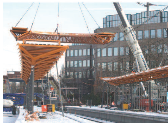
Abb. 4: Beispiel für vorgefertigte Stahlbauteile nach EN 1090-1
