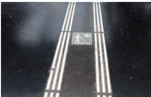
Abb. 7: Taktiles Leitsystem für sehbehinderte Menschen in einem Bahnhof
