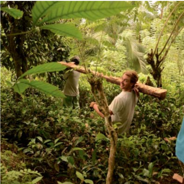
Abb. 6: DIE BAUSTELLE war für Mensch und Material nur sehr schlecht zu erreichen, es mussten Bäume gefällt und Unterholz beseitigt werden, um eine temporäre Zufahrt zu erhalten. Sie war trotzdem mühsam und gefährlich.
