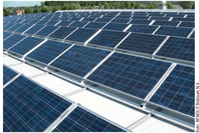
Abb. 4: Im Dezember 2014 zugelassen: Neues Befestigungssystem für Solaranlagen zur Verwendung auf Dachabdichtungsbahnen
