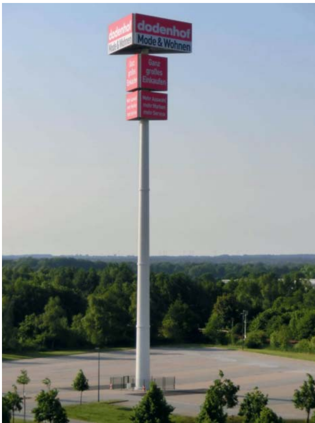
Abb. 1: In der Zulassung des DIBt: Vorgespannte Maste aus ultrahochfestem Schleuderbeton
