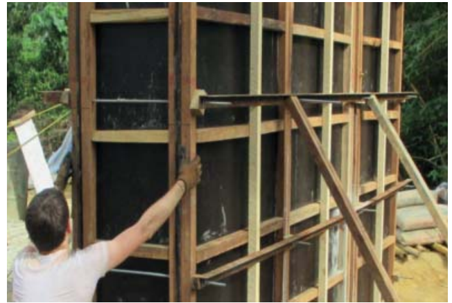
Abb. 7: DIE SCHALUNG der Marke Eigenbau warf im Verlauf des Brückenbaus immer wieder Probleme auf, und bei der Betonage des Brückenfundaments sind doch tatsächlich uns ein paar Kanthölzer durchgebrochen.
