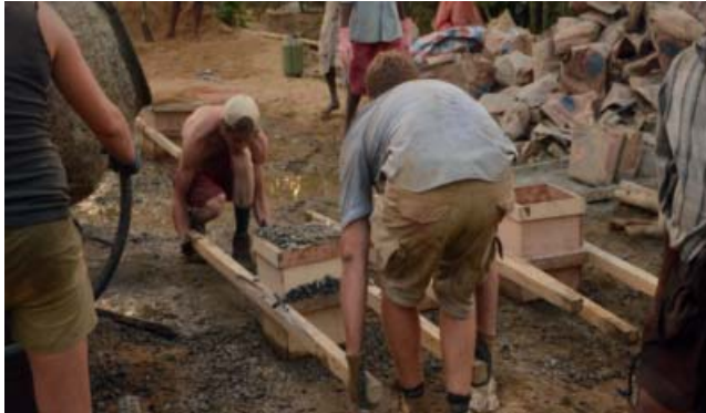
Abb. 10: DAS BETONIEREN bescherte der Studentengruppe die aufregendsten und anstrengendsten Baustellentage der ganzen dreimonatigen Bauzeit, aber gerade an diesen Tagen hatten sie eine Menge Spaß.
