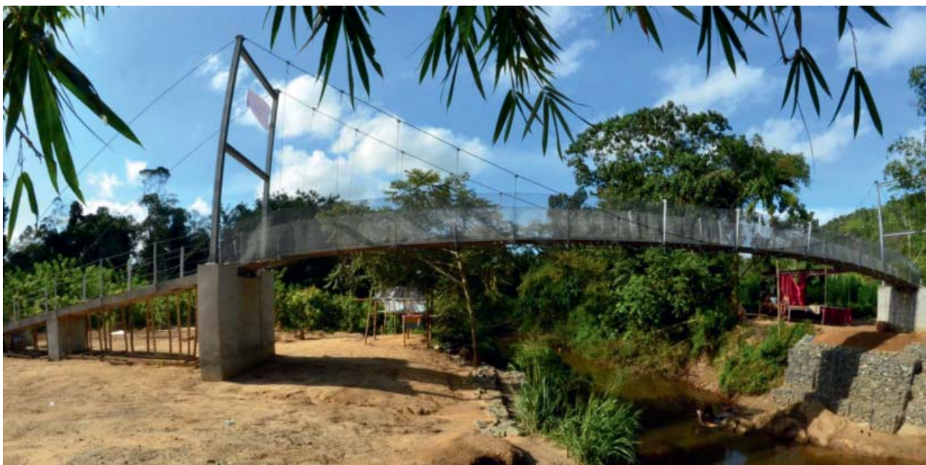
Abb. 14: DIE NEUE BRÜCKE über den Bentara-Fluss im Dschungel Sri-Lankas ist ein sichtbares und dauerhaft daran erinnerndes Zeichen dafür, dass Mut, Entschlossenheit und Leidenschaft Großes bewirken können.
