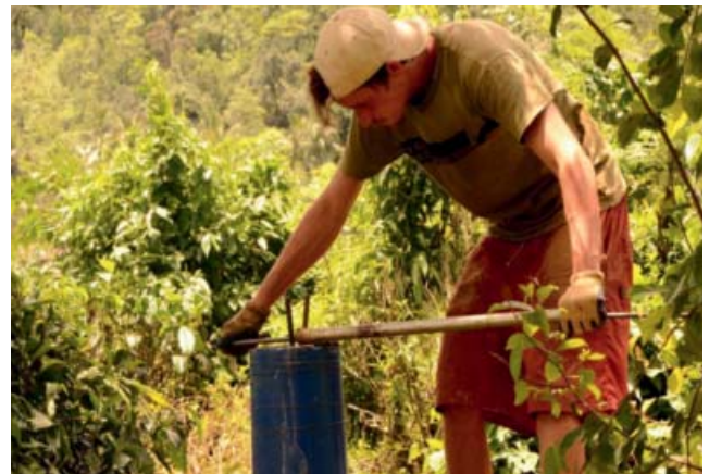
Abb. 9: JEDEN EINZELNEN BÜGEL haben die Karlsruher Studenten mit Hauruck und zusammengebissenen Zähnen auf einem Bügelblock selber gebogen – für größere Biegedurchmesser nahmen sie dann einfach eine Palme.
