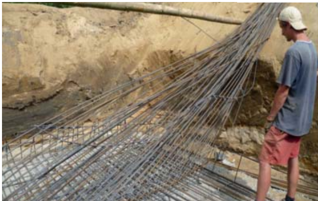
Abb. 11: DER BEWEHRUNGSSTAHL wurde eigenhändig eingebaut, es kostete die Studenten auch sehr viel Kraft und Ausdauer bis alles soweit war, dass es einem beinahe wie zu Hause vorkommen konnte, aber ...
