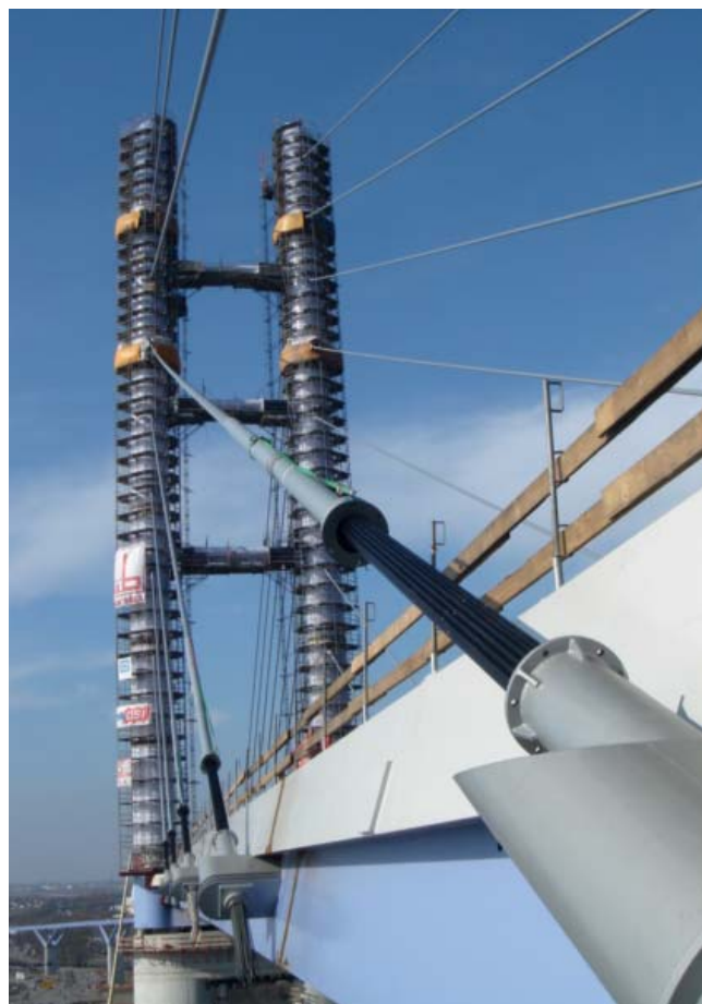
Abb. 3: Schräge Seile aus Parallellitzenbündeln brauchen künftig keine Zustimmungen im Einzelfall mehr, weil das Deutsche Institut für Bautechnik kürzlich eine erste Zulassung erteilt hat.
