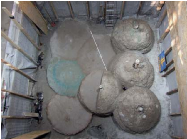
Abb. 7: Für Baugrubenabdichtungen hat das DIBt Injektionsmittel für Weichgelsohlen zugelassen, mit denen ...
