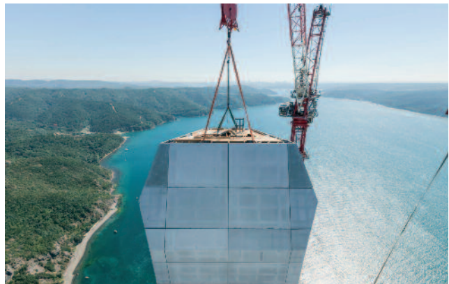
Abb. 14: Platten mit Glas- und Carbonbewehrung an der neuen Bosphorus-Brücke in Istanbul
