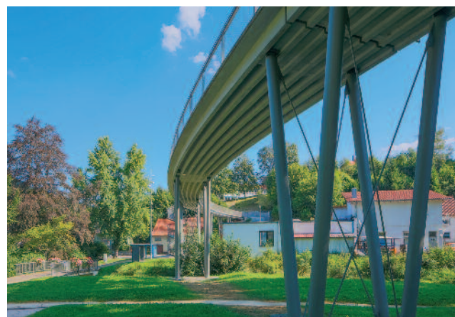
Abb. 17: Plattenbalkenbrücke aus sechs Segmenten in Albstadt-Lautlingen
