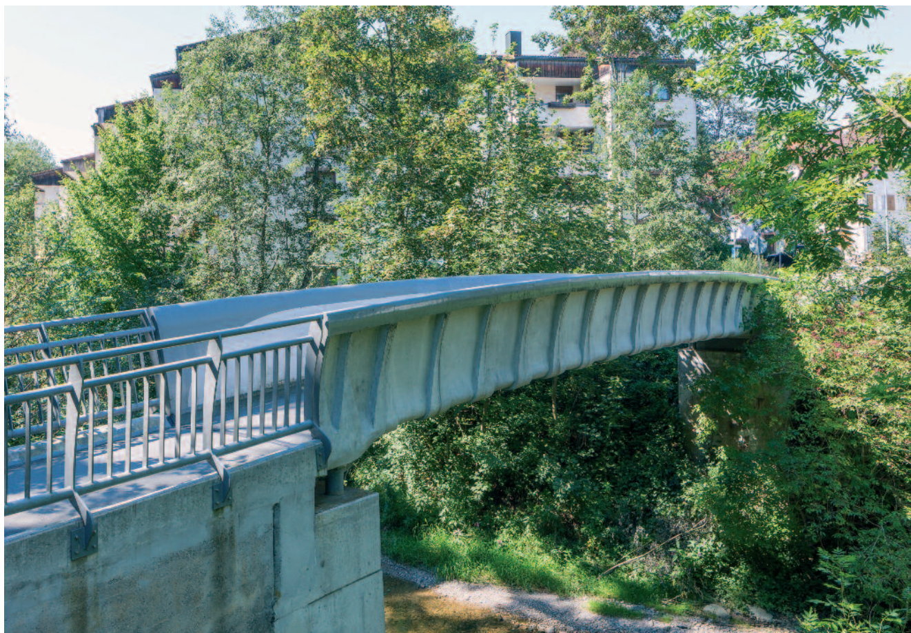
Abb. 16: Trogbrücke aus 18 Segmenten in Kempten
