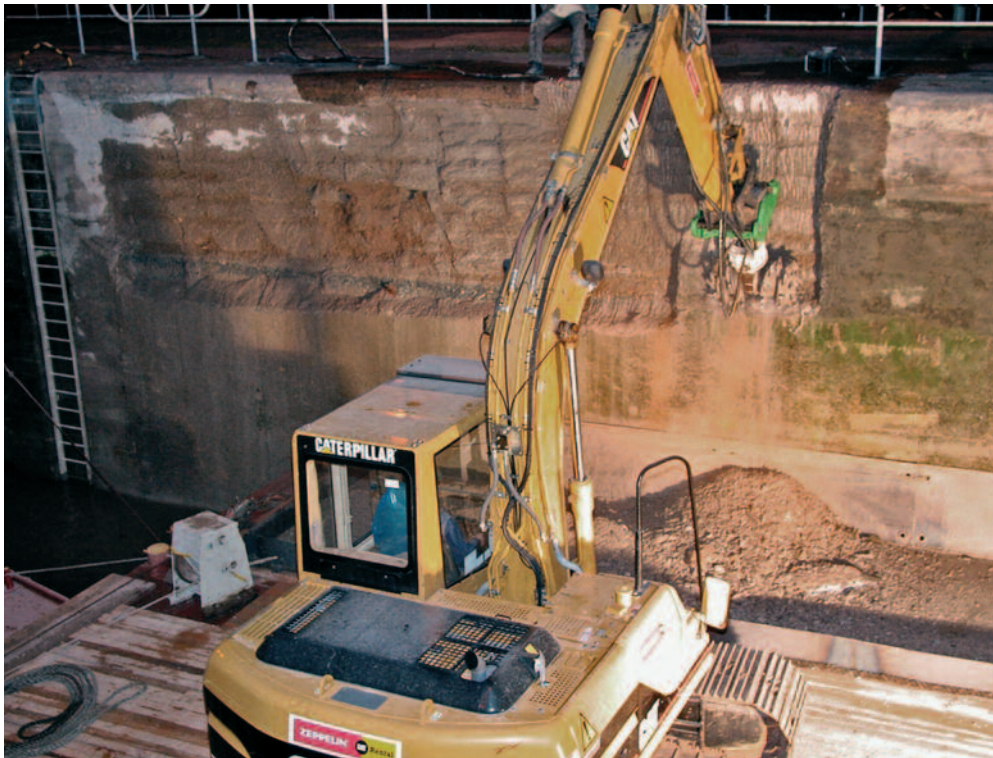
Abb. 3: Betonabtrag an der Schleuse Feudenheim während vierstündiger Sperrpausen von einem Ponton aus
