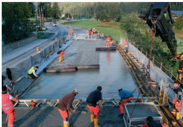
Abb. 21: Herstellung der direkt befahrbaren Carbonbetonschicht
