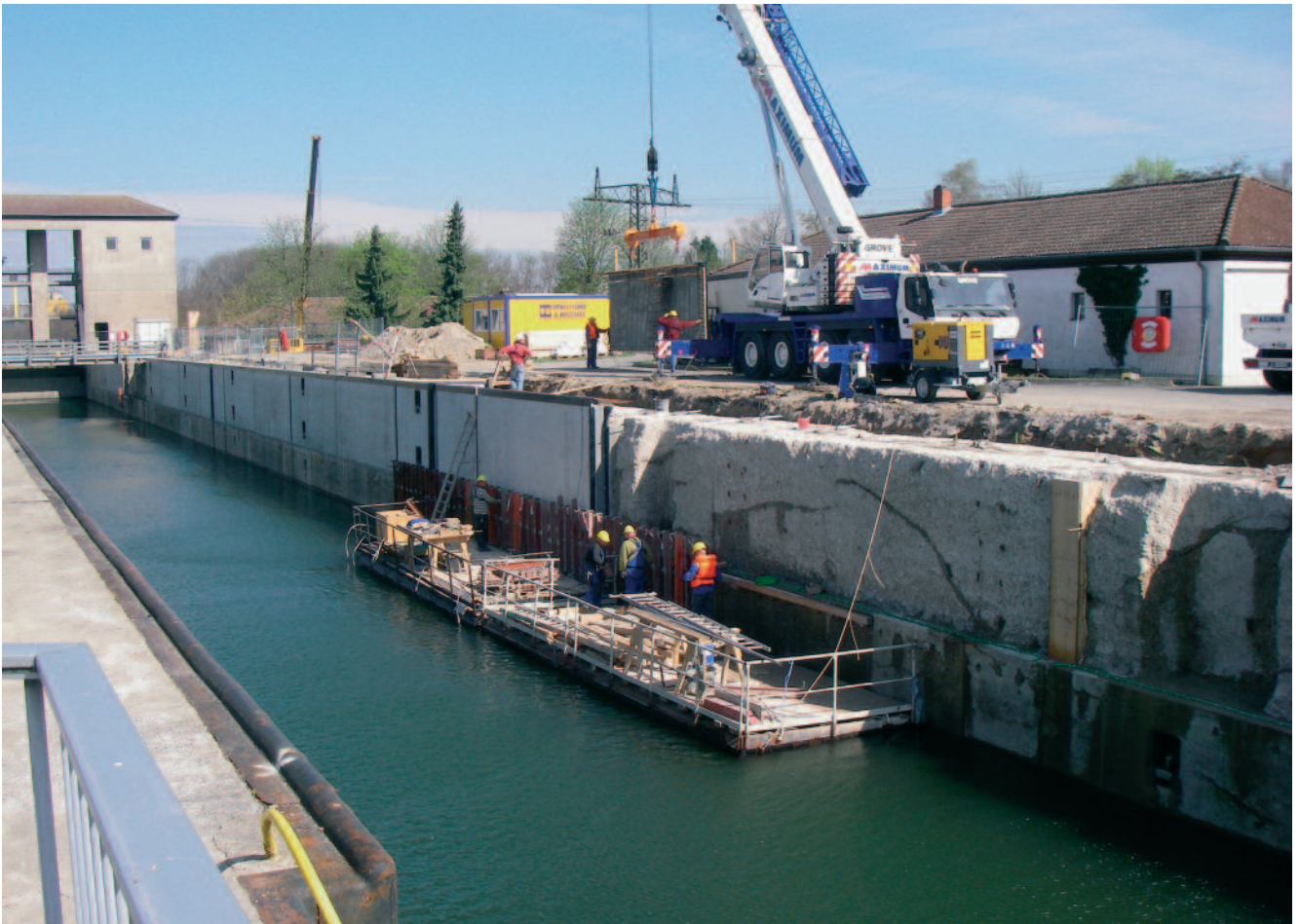
Abb. 4: Instandsetzung unter Betrieb an der Schleuse Wedtlenstedt mit Betonfertigteilen
