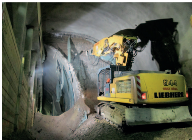
Abb. 13: Stützenreihe des Mitteltunnels und Vortrieb Seitenstollen (Kaufhofgebäude an der Königsallee in Düsseldorf)
