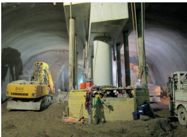
Abb. 13: Stützenreihe des Mitteltunnels und Vortrieb Seitenstollen (Kaufhofgebäude an der Königsallee in Düsseldorf)
