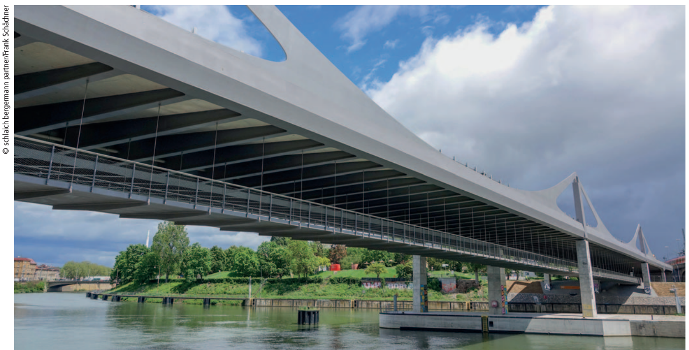
Abb. 28: Ansicht Südseite mit an Zugstangen abgehängtem Fußgängersteg
