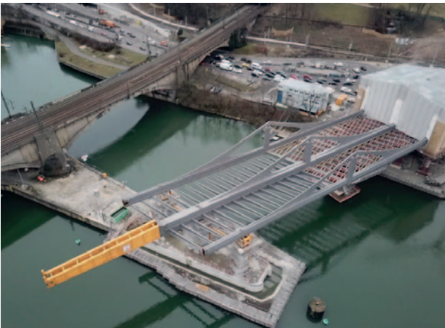
Abb. 27: Taktschiebverfahren – Vorbauschnabel über zweitem Flussfeld
