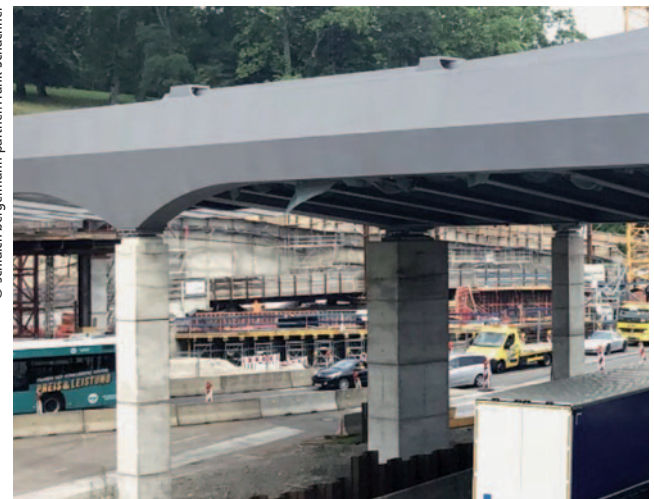
Abb. 17: Einzelpfeiler mit Kalottenlager
